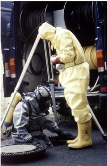
Einstieg unter Vollschutz in bis 8 m tiefe Kanalschächte. Ausbau von TNT aus Kanalrohren.
